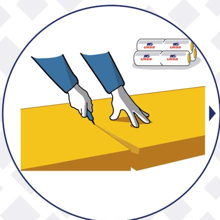
Odrežeme nameranú časť minerálnej izolácie URSA. Rez vykonávame pozdĺž prítlačnej lišty (časť OSB dosky, kovový profil a pod.). Špeciálnym nožom URSA určeným na rezanie izolácie.
