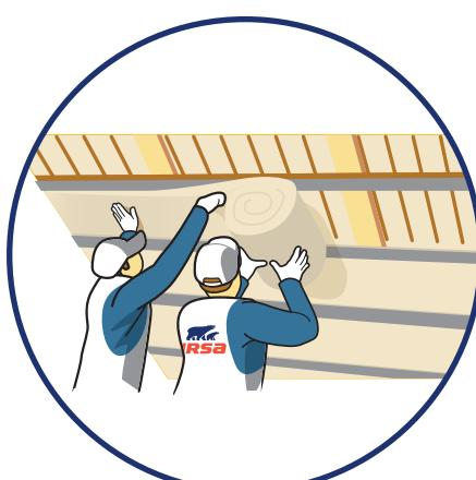
Aplikácia minerálnej izolácie URSA PUREONE SF 31 do priečneho kovového roštu upevneného na krovky, ako druhá tepelnoizolačná vrstva. Izoláciu vkladáme l'ahkým vtlačením po celej dĺžke roštu. Dbajte rovnakých zásad ako v predošlom aplikačnom kroku.
