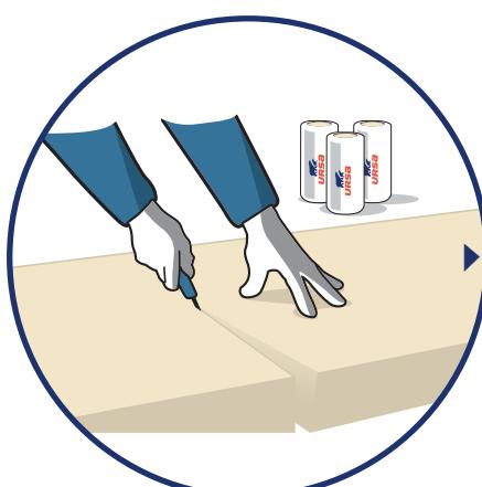
Odrezeme nameranú časť minerálnej izolácie URSA PUREONE SF 31. Rez vykonávame pozdĺž prítačnej lišty (časť OSB dosky, kovový profil a pod.) špeciálnym nožom URSA určeným na rezanie izolácie.
