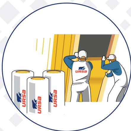
Aplikácia minerálnej izolácie URSA PLATINUM 32 medzi krokvi. Izoláciu medzi krokvi postupne vkladáme ľahkým vtlačением po oboch stranách jej výšky, až zaplníme celé krokrové pole. Na zabezpečenie izolácie v krokrovom poli pri aplikácii môžeme použiť fixačné prvky napr. drôtovanie.
